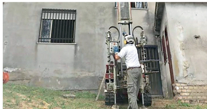
I lavori per la costruzione di un ascensore esterno in municipio
